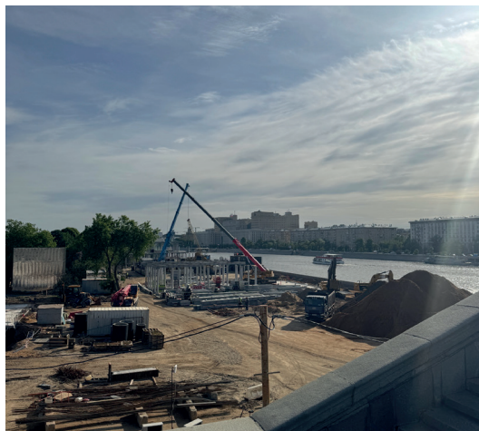
Рис. 6. Обновление Крымской набережной в 2025 г. Источник: фотографии автора.
