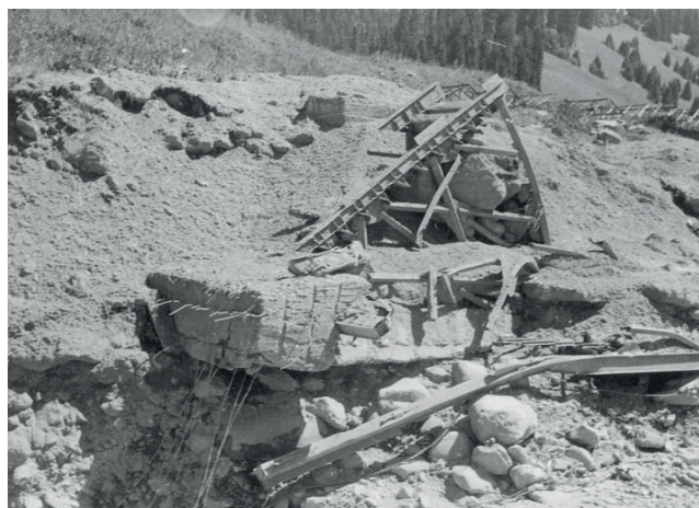
Обломки одной из селезащитных ловушек, полностью разрушенных селевым потоком
