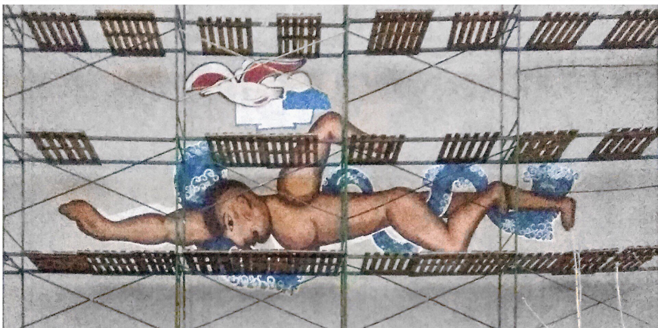
Рис. 2. Мозаичное панно «Пловец» до и после ремонта фасада здания Источник: https://twitter.com/fondvnimanie/status/1061327439241068544
