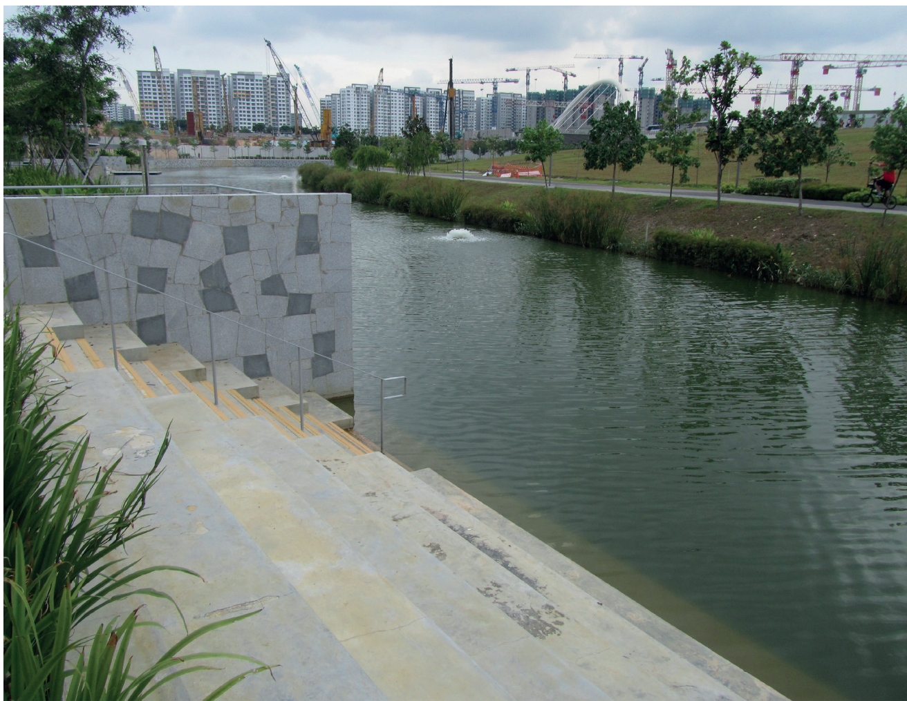
Рис. 3. Строительство вдоль искусственного водного пути в Пангголе
